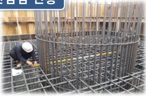
교량 공사중점검 현황 (제원조사)
