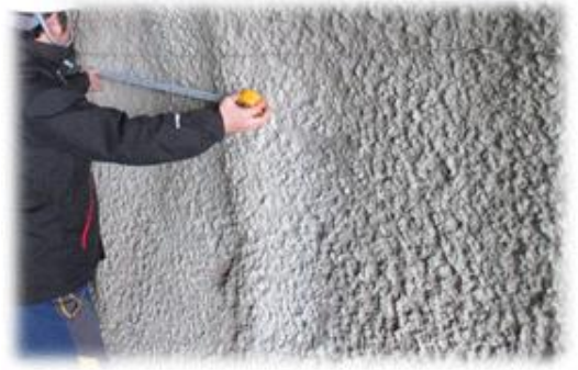
터널 공사중점검 현황 (제원조사)
