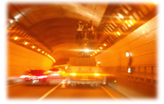
터널 정밀점검 현황 (외관조사)
