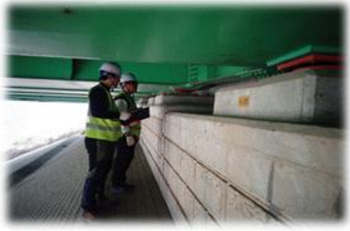
교량 정밀점검 현황 (외관조사)
