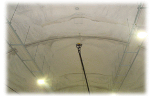
터널 정밀안전진단 현황 (G.P.R 탐사)
